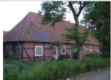
*An diesem Fachwerkhause passen die Fensteraufteilungen nicht. Der Fußbalken ist schadhaft und muss ausgetauscht werden. Auch das Dach muss erneuert werden.*
