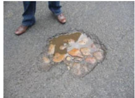
*Unter der dünnen Asphaltdecke kommt das Kopfsteinpflaster wieder hervor.*
