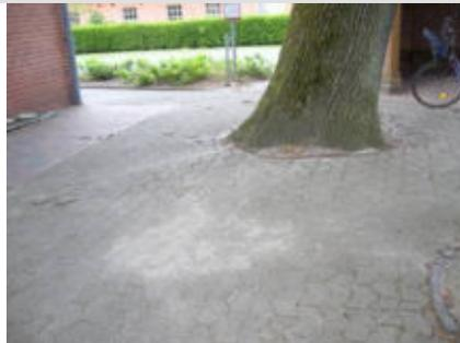
*Allerdings haben die Wurzeln zu wenig Platz, so dass das Pflaster hochgedrückt wird.*
