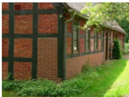
Das Gefach wurde durch Ziegelsteine ausgebessert. Die Gefachbalken wurden aber entfernt.
